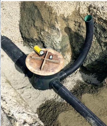
Kontroll- und Spülschacht MULTI-inspect DUO für Huckepackanordnung mit seitlichem Anschluss DN 150 Straßenablauf
