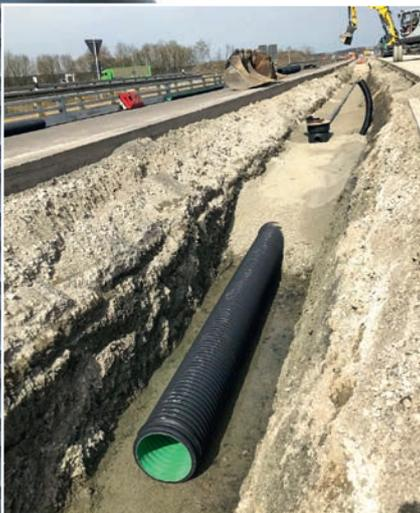
Verlegung Transportrohr AQUATUB-Rw und Sickerrohr SIROPLAST-K in Huckepackanordnung
