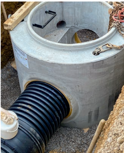
Fachgerechte Rohranbindung an den Betonschacht mit Spezialschachtfutter aus dem AQUATUB-Rw-Sortiment
