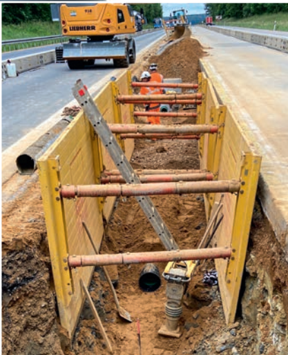
Verlegung der Kurzrohre (3-m-Stangen) AQUATUB-Rw zwischen den Querstreben der Verbauplatten
