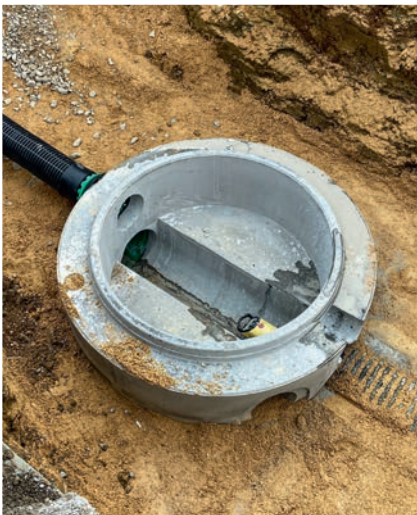
Ausführung teilweise in Huckepackanordnung in Kombination AQUATUB-Rw und SIROPLAST-K
