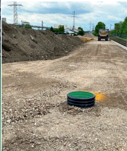
In der Hallenumfahrt verlegter Stauraumkanal DN 800 mit Inspektionzugang über Schachtsystem MULTI-inspect 600
