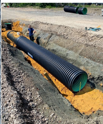
Im Gefälle ausgerichteter Stauraumkanal DN 800 auf fachgerechter Sandbettung
