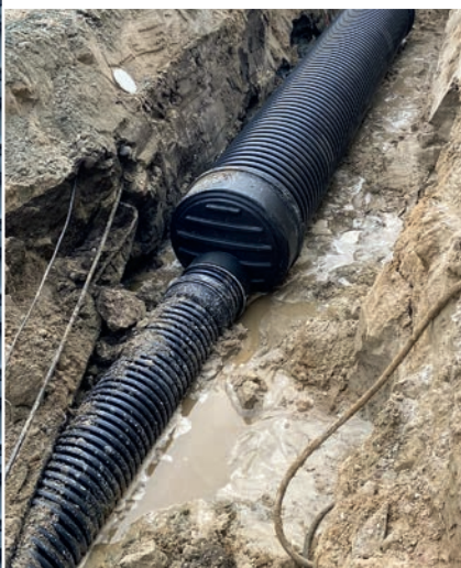
Monolithisch geformte Reduzierung der Rückhaltung DN 800/DN 400
