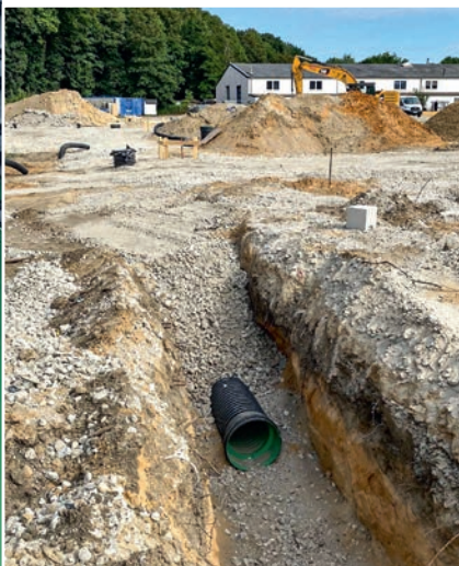
Zügige und einfache Verlegung der Stauraumkanalrohre AQUATUB-Rw DN 800
