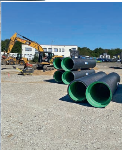
Anlieferung und Verteilung von Stauraumkanalrohr AQUATUB-Rw DN 800 am Baufeld
