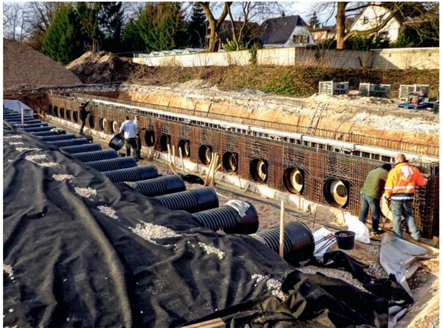
Regenrückhaltung mit mehrfach verlegten Stauraumkanalrohren AQUATUB-Rw DN 600 und Anbindung an ein Verteilerbauwerk in Ortbetonbauweise (Betonriegel)
