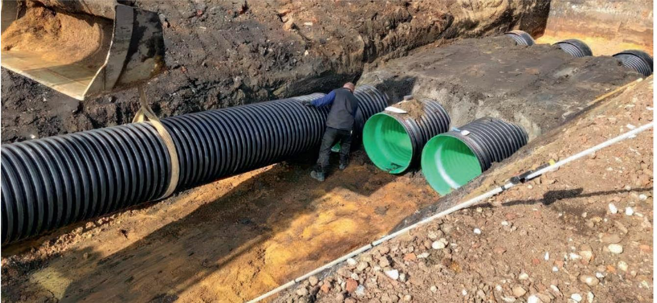
Einfaches Handling und zügiges Verlegen der Nennweiten DN 800 bei großen Stauraumvolumen
