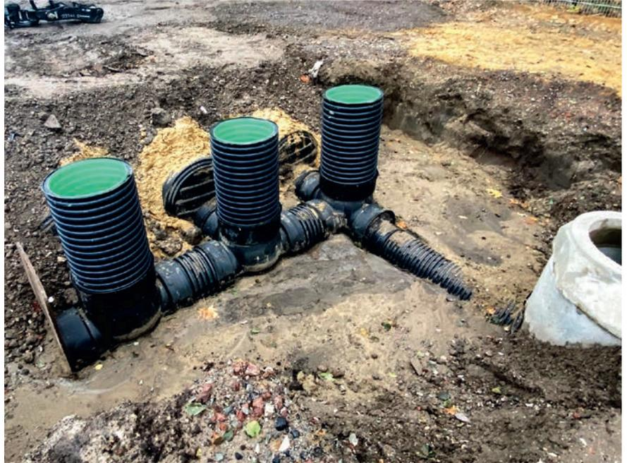
3-Strang-Stauraumkanal in Kombination mit Verteiler-Schachtelementen MULTI-inspect 600 und Anbindung an die örtliche Vorflut (Betonschacht)
