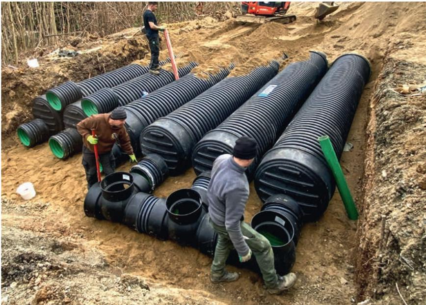
Stauraumkanal DN 800 mit MULTI-inspect-Verteilerschächten
